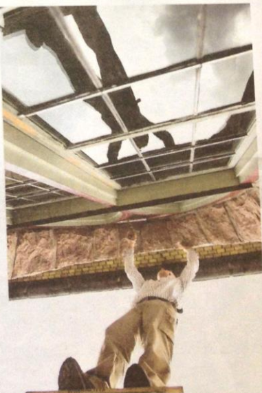
De renoverade fönstren är målade med linoljefärg och nyansen är den samma som när fönstren först sattes upp. Varje fönsterbåge är unik och passar bara på ett ställe. Cirka två månader har renoveringen tagit.
